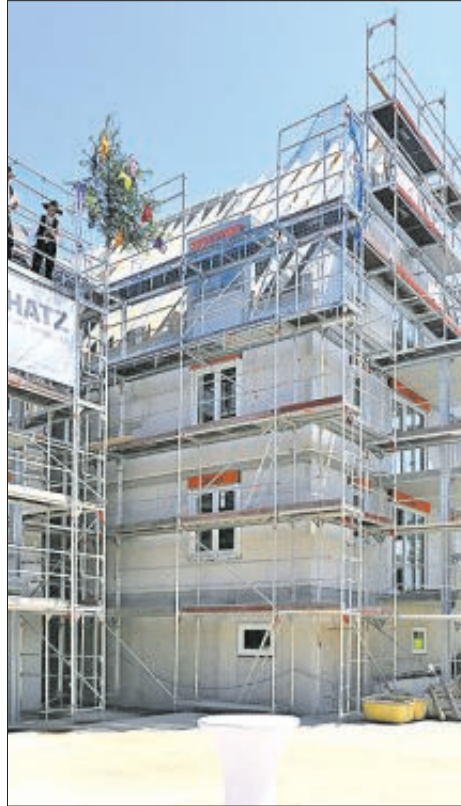
Zimmermeister Alfons Rieg lieferte vom Dach her den Richtspruch.
