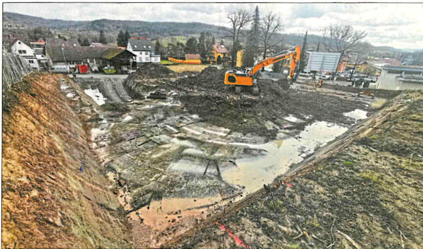
Wo einst die Villa Bürglen stand, ist jetzt eine Baugrube.
