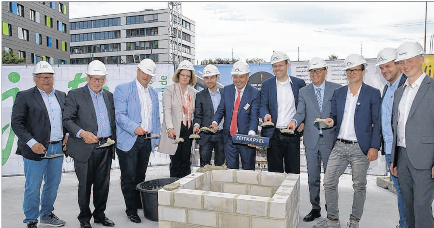
Grundsteinlegung auf der Baustelle für die Kita und die Mikroappartements. In der Mitte Projektentwickler Peter H. Kemmer (rote Krawatte), eingerahmt von Heike Barth (Geschäftsführerin der Stinag) und Böblingens OB Dr. Stefan Belz (auf der linken Seite) und von Sindelfingens OB Dr. Bernd Vöhringer sowie Peter Brenner (Geschäftsführer des Zweckverbands Flugfeld) auf der rechten Seite.
